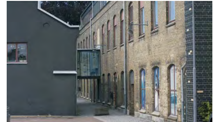
Strykjärnsgränden med förbindelsegång mellan de två byggnaderna kontoret och Strykjärnet.
